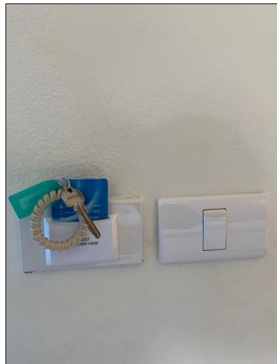
รูปภาพที่ 2.18 ระบบคีย์การ์ด ควบคุมการเปิด-ปิด ภายในห้องพัก
