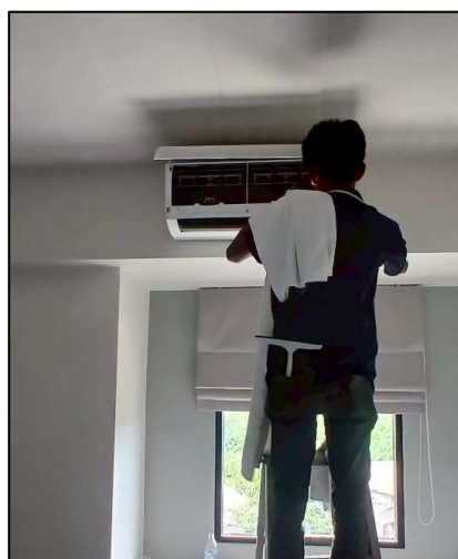
รูปภาพที่ 2.37 การล้างเครื่องปรับอากาศ
