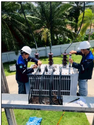
รูปภาพที่ 2.39 การตรวจสอบหม้อแปลงไฟฟ้า
