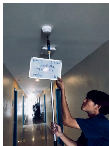
รูปภาพที่ 2.40 การตรวจสอบอุปกรณ์ป้องกันอัคคีภัย
